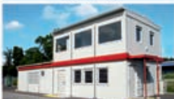
Zusätzlicher Raum im Betrieb
